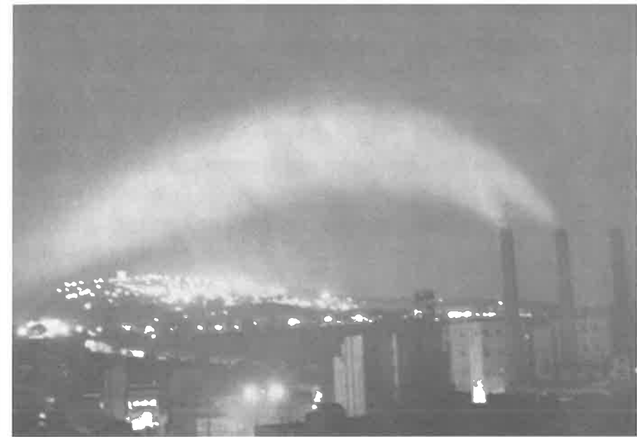
Figura 3.3 A) Formació d'una cúpula d'aire contaminat damunt una ciutat. B) Fotografia de la ploma de fum despesa per les xemeneies de la central tèrmica del Paral·lel, quan estava en activitat, en condicions d'inversió. (Foto: Juan B. López Cayetano, del 24-9-1969.)
