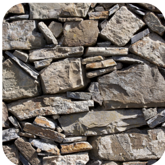
Paret de pedra seca
